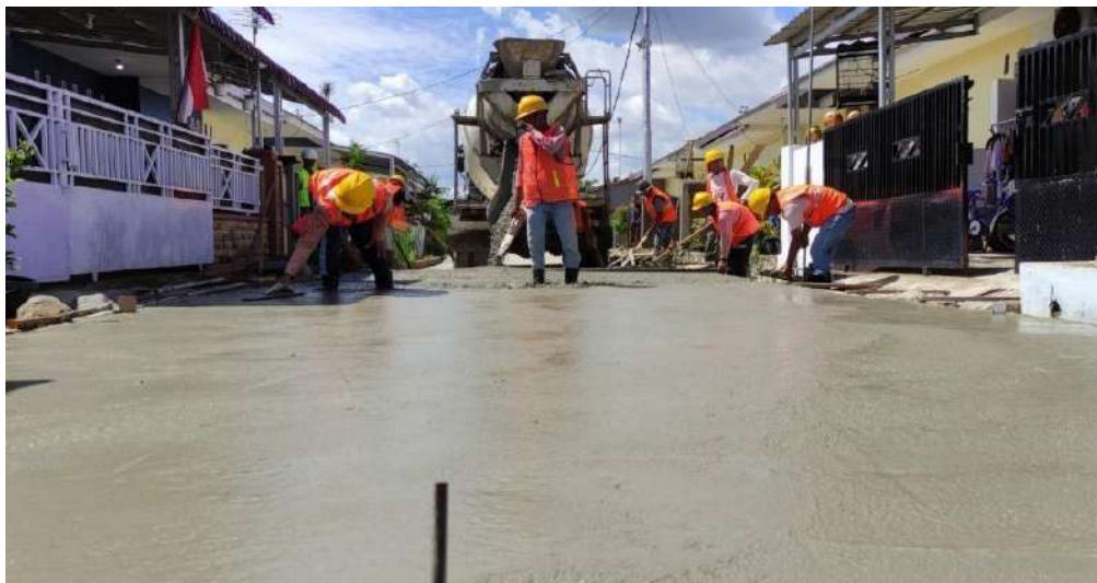
Gambar III-29 Contoh Pelaksanaan Pekerjaan Perkerasan Beton Semen
