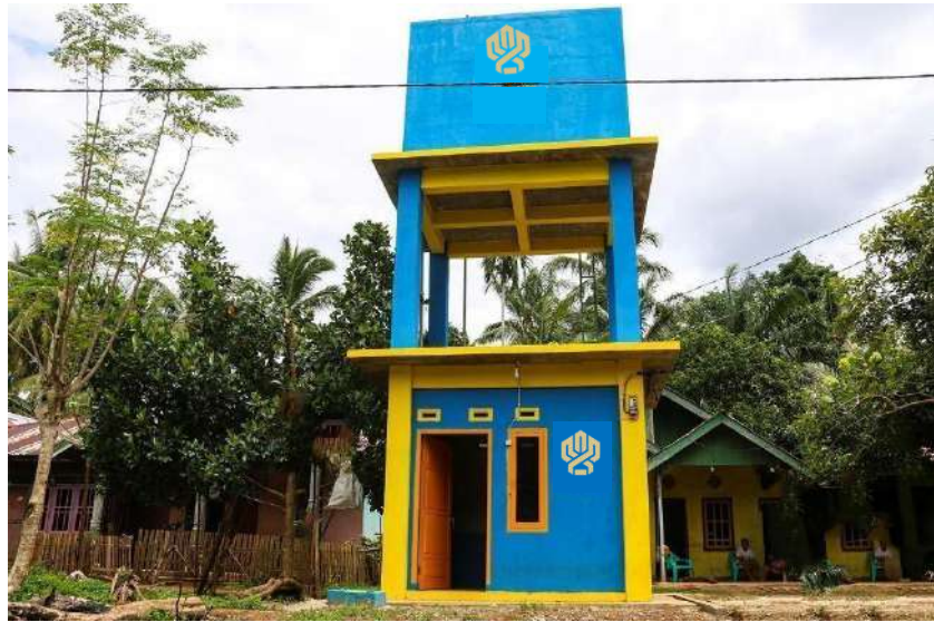
Gambar I-23 Contoh Reservoir Menara (Elevated Reservoir) dengan Material Beton
