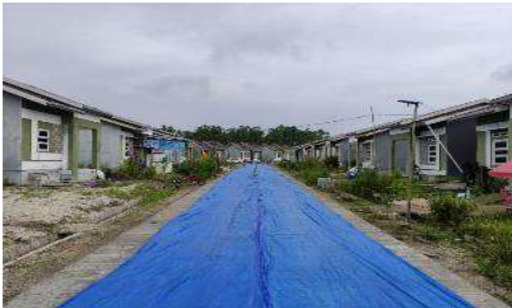
Gambar III-30 Contoh Pemasangan Plastik Fondasi
