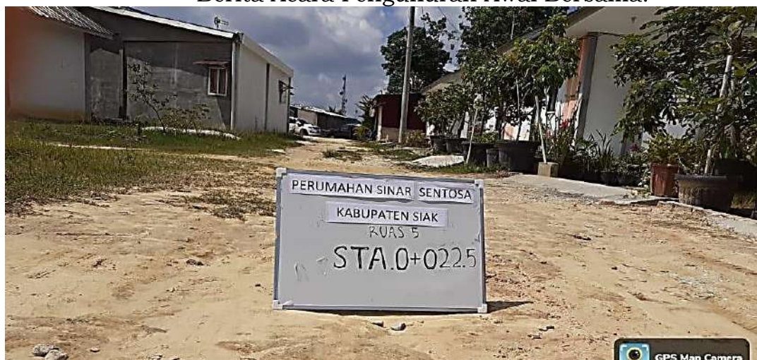
Gambar III-23 Contoh Penentuan Titik Nol Pada Lokasi Pembangunan
