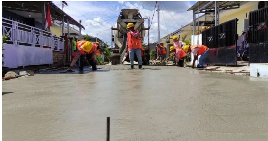
Gambar I-50 Contoh Pelaksanaan Pekerjaan Perkerasan Beton Semen
