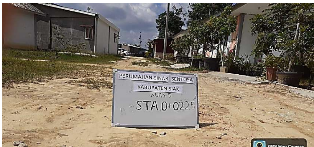
Gambar I-44 Contoh Penentuan Titik Nol Pada Lokasi Pembangunan
