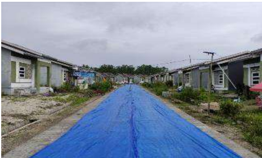
Gambar I-51 Contoh Pemasangan Plastik Fondasi
