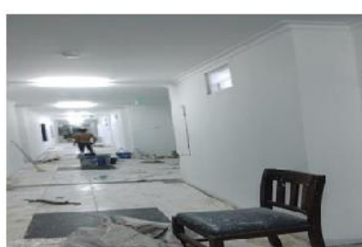
Pek. Pembersihan Lokasi Kerja TB2
