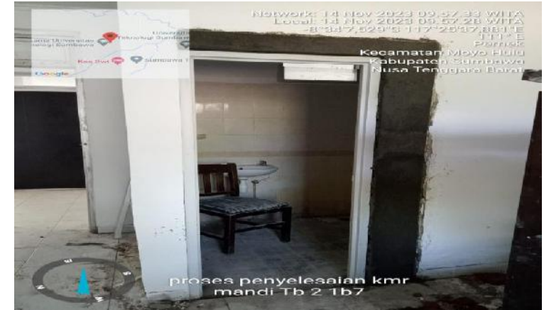
Pek. Pemasangan Pintu KM/WC
