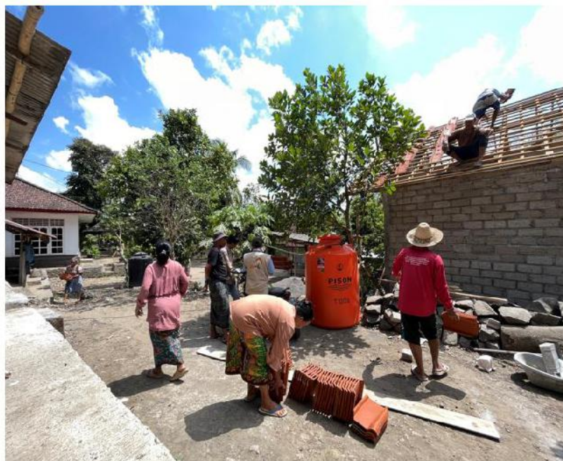
Warga Desa Rembitan yang tengah bergotong royong membawa bahan bangunan dalam pelaksanaan konstruksi Lokasi : Desa Rembitan, Kecamatan Pujut, Kabupaten Lombok Tengah
