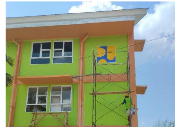
Pek. Pembuatan dan Pemasangan Logo PUPR Acrylic 80 x 80 t=3mm
