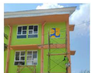
Pek. Pembuatan dan Pemasangan Logo PUPR Acrylic 80 x 80 t=3mm
