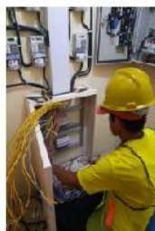
Pek. Perakitan dan Pemasangan Panel TB. Box MCB
