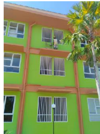
Pek. Pengecatan Besi Grill Fasad
