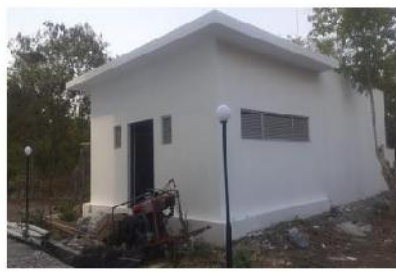
Pek. Pengecatan Rumah Pompa 100%
