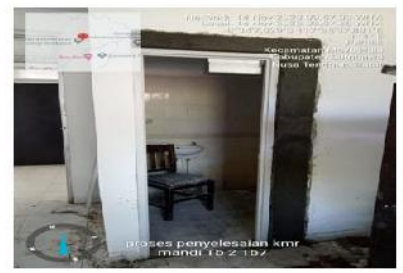
Pek. Pemasangan Pintu KM/WC
