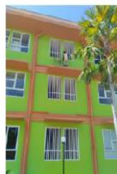
Pek. Pengecatan Besi Grill Fasad
