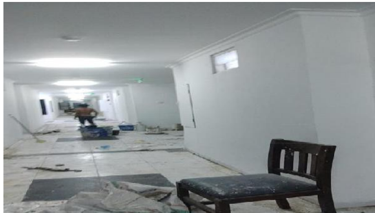
Pek. Pembersihan Lokasi Kerja TB2
