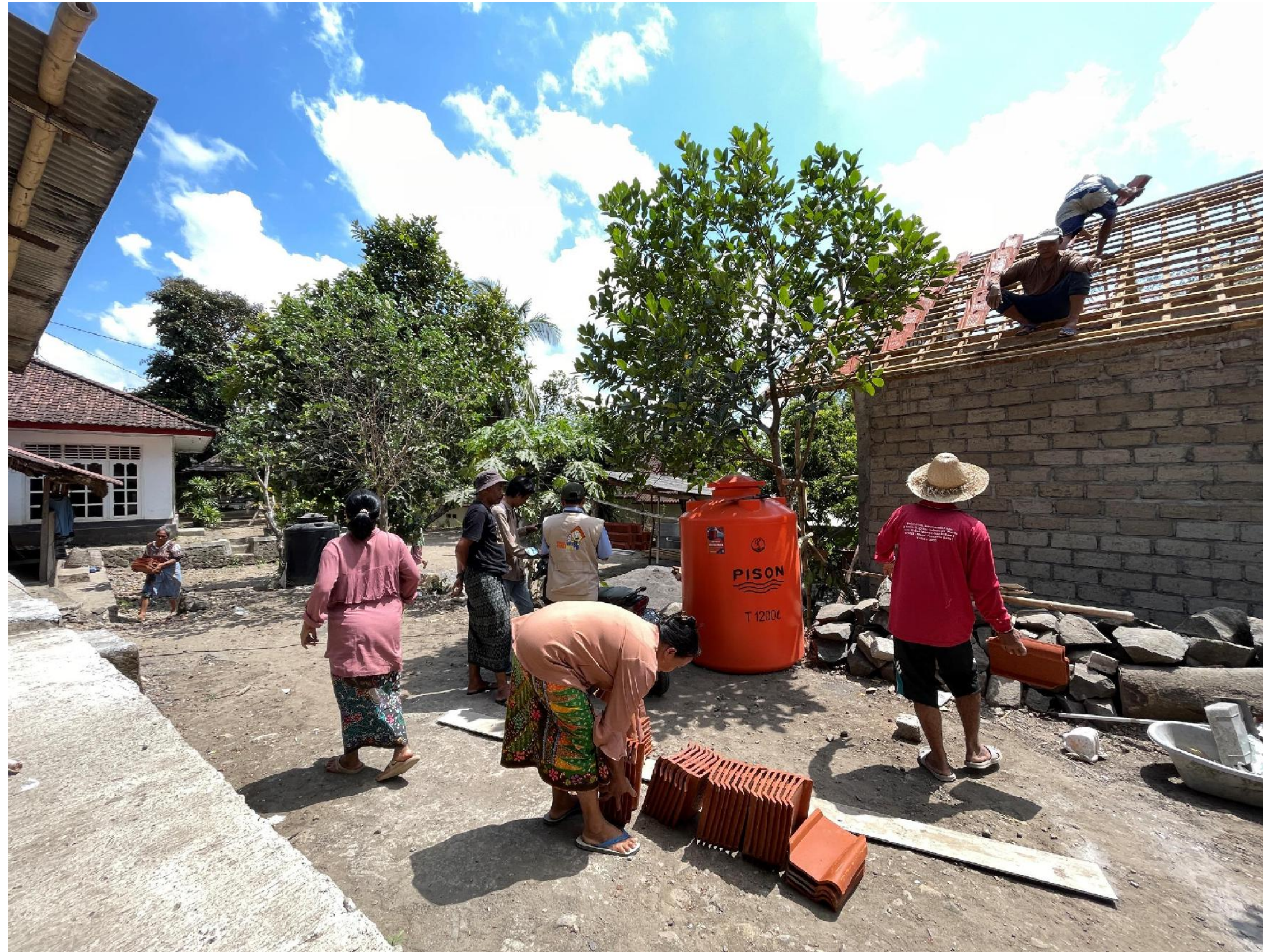
Warga Desa Rembitan yang tengah bergotong royong membawa bahan bangunan dalam pelaksanaan konstruksi Lokasi : Desa Rembitan, Kecamatan Pujut, Kabupaten Lombok Tengah
