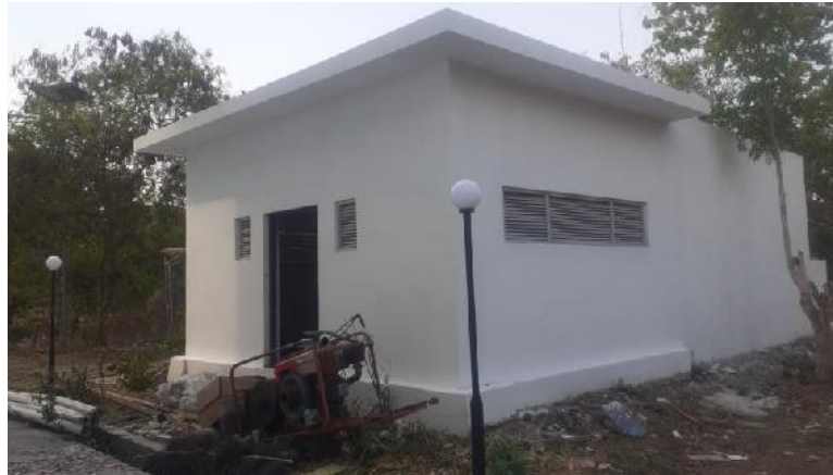
Pek. Pengecatan Rumah Pompa 100%
