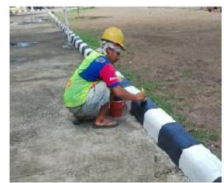
Pek. Pengecatan Kansteen
