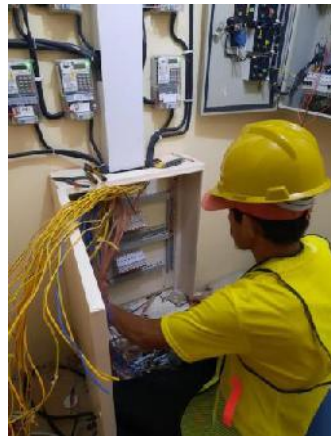
Pek. Perakitan dan Pemasangan Panel TB. Box MCB
