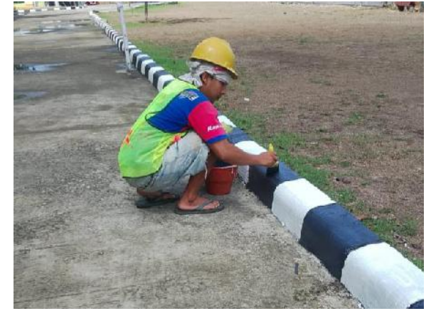
Pek. Pengecatan Kansteen
